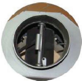
Рис.4.1. Положение заслонки при открытой двери
